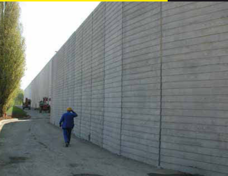
Murs de grande hauteur 8,00 m Parement matricé bois CHENNEVIÈRES SUR MARNE (94) (Pose NEC)
