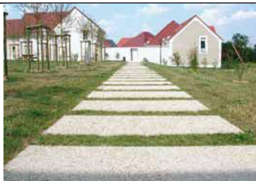
Grandes dalles GL MAGNY LE HONGRE (77) (Pose NEC)
