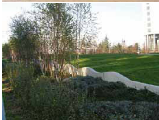
Murs en forme de vague d'épaisseur constante L = 3,00 m et 6,00 m ROISSY (95) (Pose COLAS)
